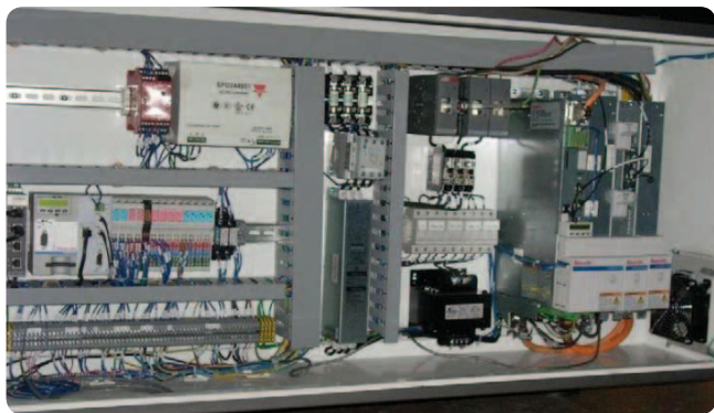
Obr. 1 Po rekonštrukcii – pohony sa presunuli z riadiacej skrinky priamo na stroj.
